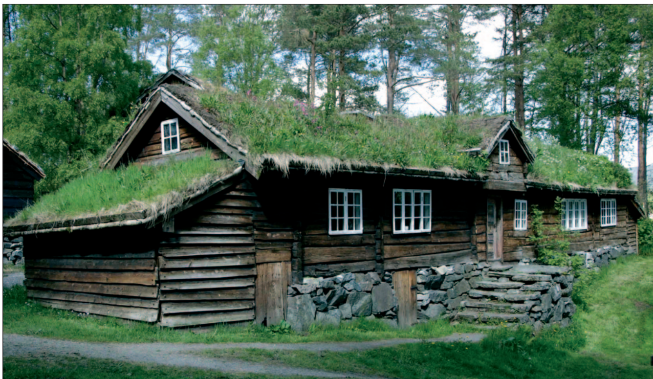
Bakkestova frå Habostad, Stranda. Kårstova, inn til venstre, vart bygd i 1867. Storstova, inn til høgre, erstatta ei eldre stove i 1876. Slike stovehus, der fleire generasjonar budde saman, var vanlege på gardane på indre Sunnmøre i andre halvdel av 1800-talet.
